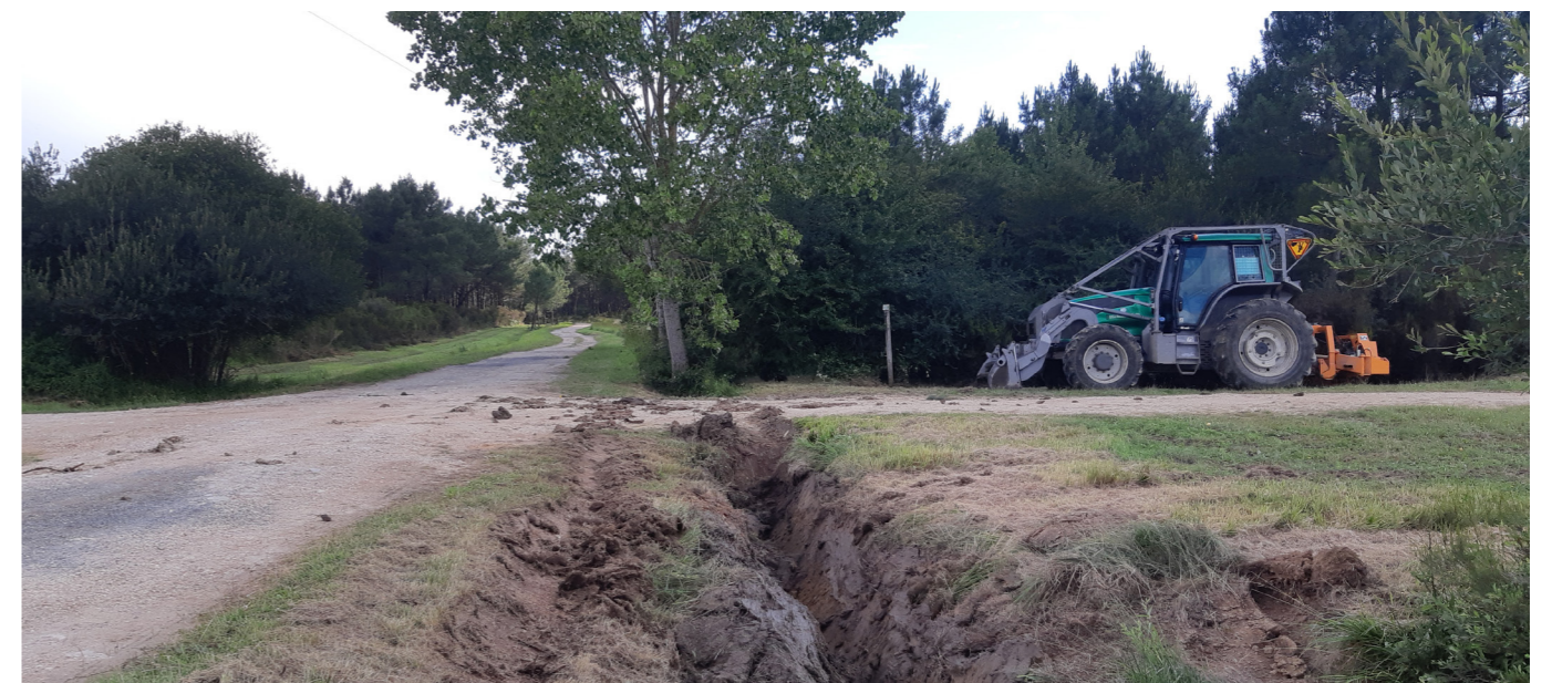
Entretien de fossé de drainage en bordure de chemin sur la zone humide du Pinail © K. Lelarge
